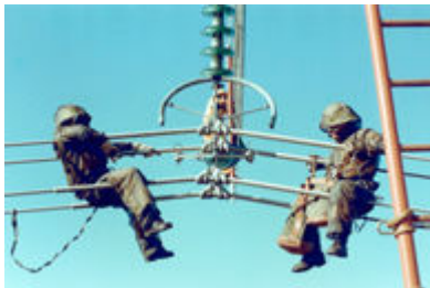
Trabalhadores realizam checagem em linha de transmissão. Os equipamentos especiais utilizados seguem os rígidos padrões de segurança da Cesp.
