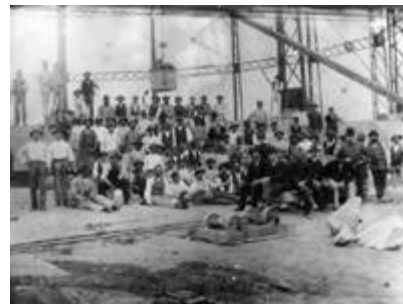
Grupo de trabalhadores na construção do Gasômetro nº 1 na Rua da Figueira, Brás (São Paulo), 1890. Ao fundo, o Gasômetro com a sua estrutura metálica externa de sustentação já erguida. No centro superior, caçamba com pedras segurada por um trabalhador. Em primeiro plano, à direita, os trabalhadores-chefes trajando terno completo e chapéu. A função de outros funcionários pode ser identificada pelos instrumentos de trabalho que estão portando (carpinteiros, pedreiros). Nota-se no grupo alguns trabalhadores negros, entre a maioria de feições européias.
