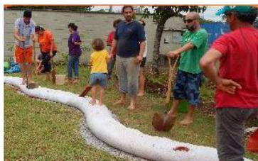
O que garantirá o acabamento do superadobe é a compactação da terra. Essa técnica é estrutural, então ela dispensa pilares e vigas no momento da construção.
