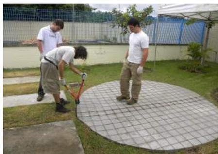
Coloque a malha de ferro por cima da argamassa cobrindo toda a área e deixando 15 centímetros de sobra em toda a circunferência. É na sobra que a parede será amarrada.
