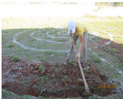
Encaixe as telhas dentro das valas e complete as bases com terra, que deverá ser compactada com a ajuda de um cabo de ferramenta.
