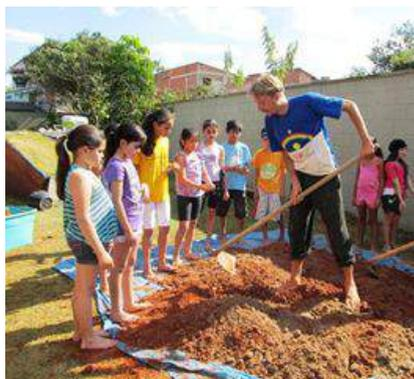
A água é adicionada aos poucos e inicia-se a mistura com os pés. A quantidade de água usada varia com a quantidade de massa que estiver sendo feita. A massa deve chegar a uma consistência mais sólida, não pode apresentar muita umidade.
