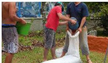
O saco deve ser cortado, no comprimento da parede desejada, e preenchido com terra, de preferência levemente úmida. Em seguida, comece a compactação. Para realizar a subida das paredes/ formas, o arame farpado deve ser inserido entre os sacos, formando assim as camadas.
