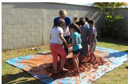
Utiliza-se apenas uma pequena quantidade de fibra vegetal, para o aumento da resistência. A mistura da massa deve ser bem homogênea.
