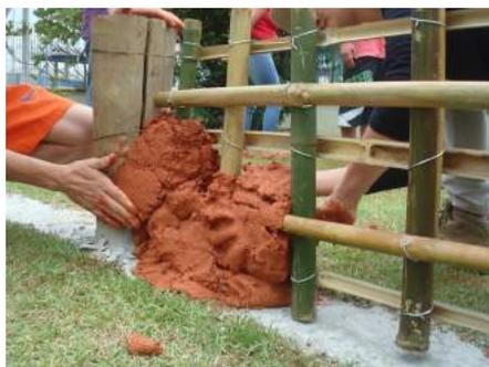
**Utilização da massa:** a partir da estrutura de bambu, duas pessoas com a mesma quantidade de massa, precisam arremessá-la em sentidos opostos para fixação e retirada de oxigênio da mesma. Assim as paredes vão sendo levantadas. E para finalizar a construção, usa-se o reboco natural.
