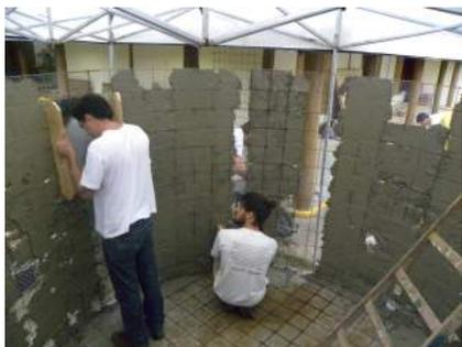
Faça a massa na proporção de duas partes de areia para uma parte de cimento. Adicione a água aos poucos – a massa precisa estar maleável.
