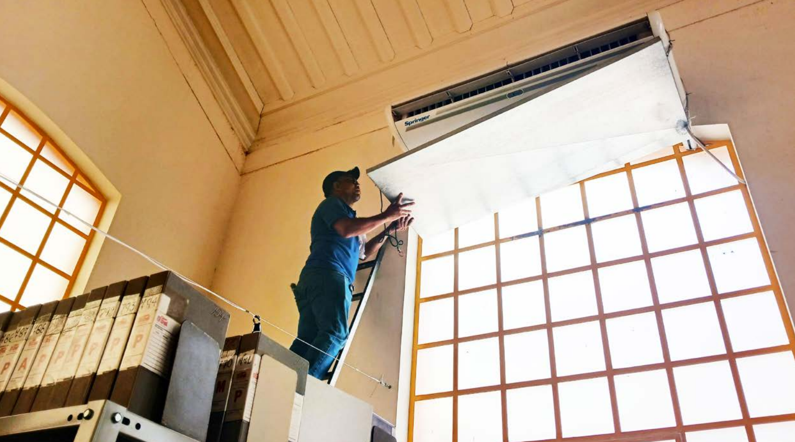
Manutenção dos equipamentos de climatização do acervo. Foto: Registro interno
